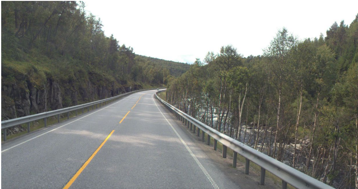
Figur 3 Tunna nord for Tunna bru (Vegbilder 2024)
