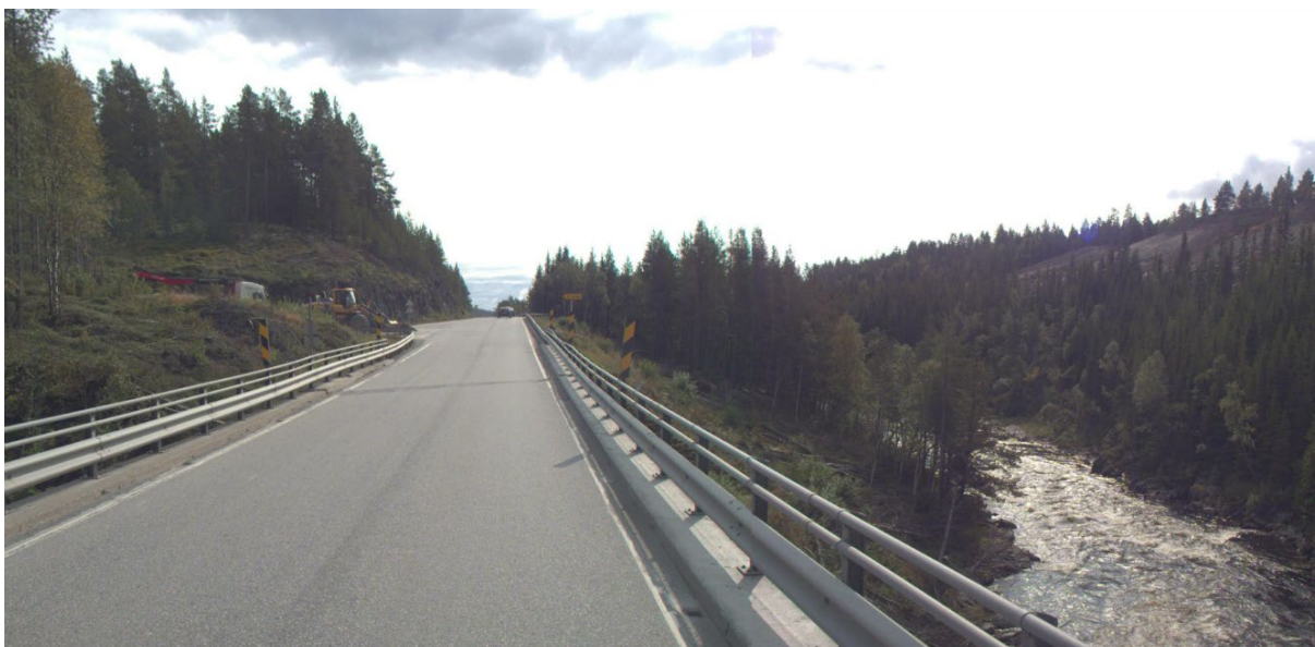
Figur 5 Tunna sør for Tunna bru (Vegbilder 2024)
