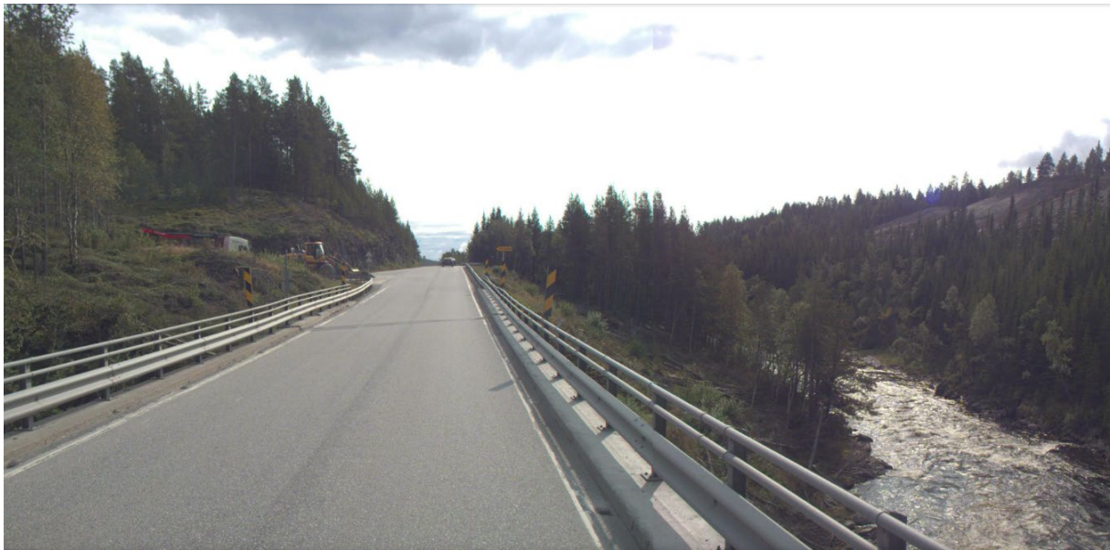
Figur 2 Tunna nord for Tunna bru (Vegbilder 2024)
