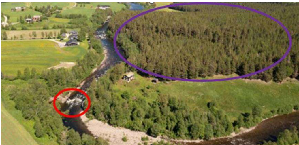
Fig.2. Oversiktsfoto over tiltaksområde. Demning blir plassert ved stryk vist i bildet (rød sirkel).
