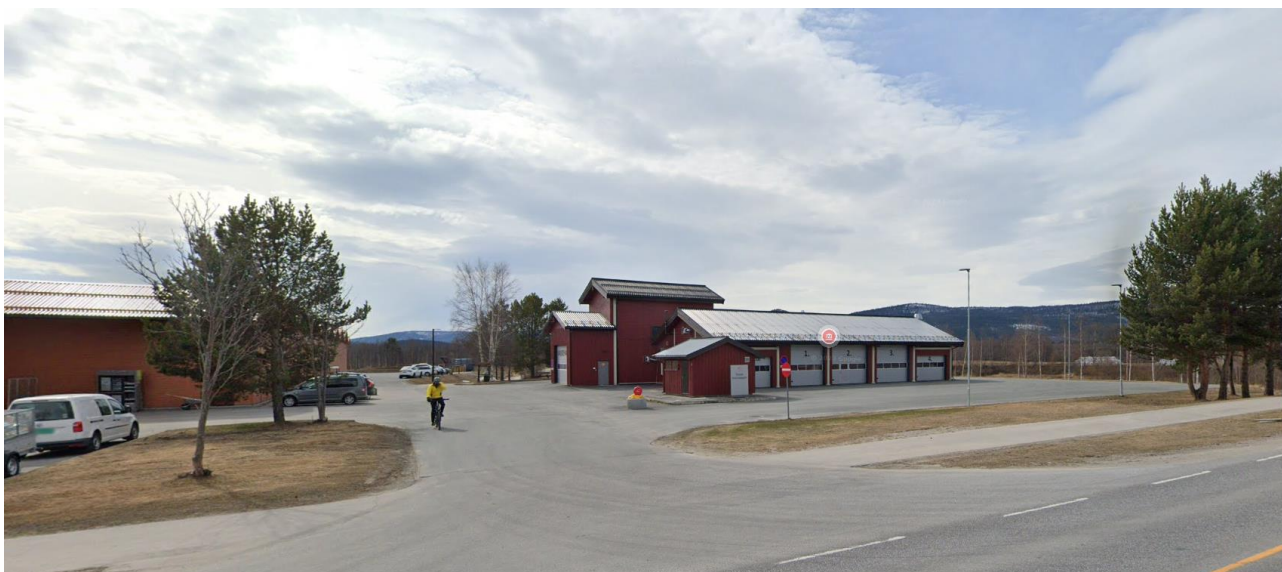
Figur 26 Domus til høyre og brannstasjonen til venstre
