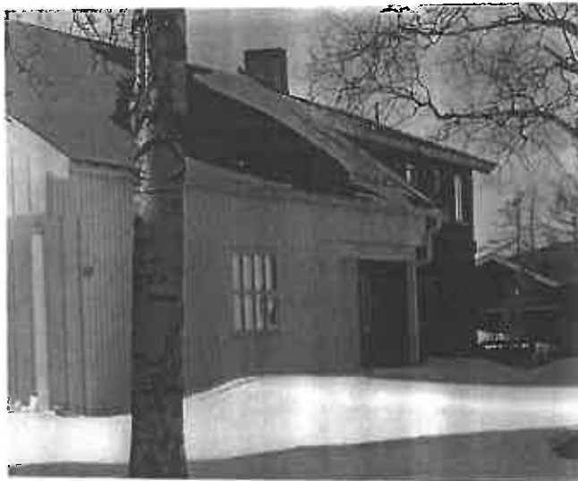
Panelt vegg som "hud" rundt limtrekonstruksjonen.
