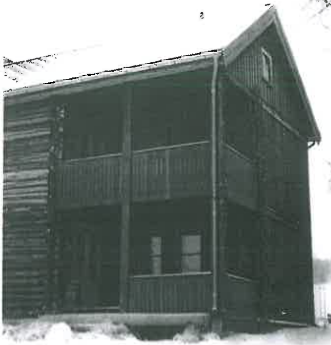
Nytt tilbygg med svalgang.
