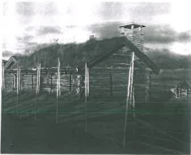
Gjenbruk og flytting av et gammelt tømmerhus er en god løsning for bygging på setervangen.
