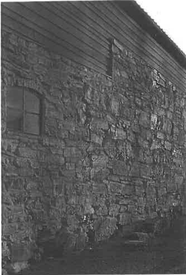
"Grunnmuren" er her den vesentligste del av veggflaten.
