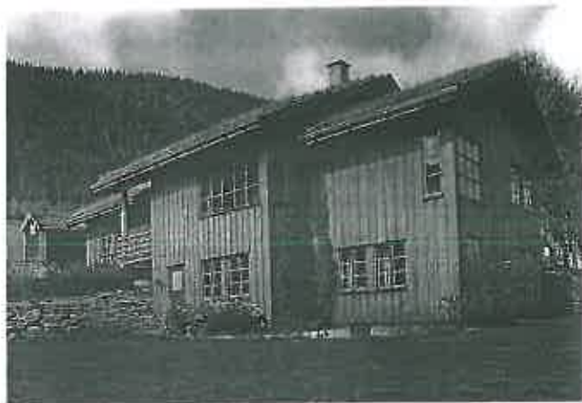
Gårdsbebyggelse: Torvtak, trepanel, natursteinsmur.
